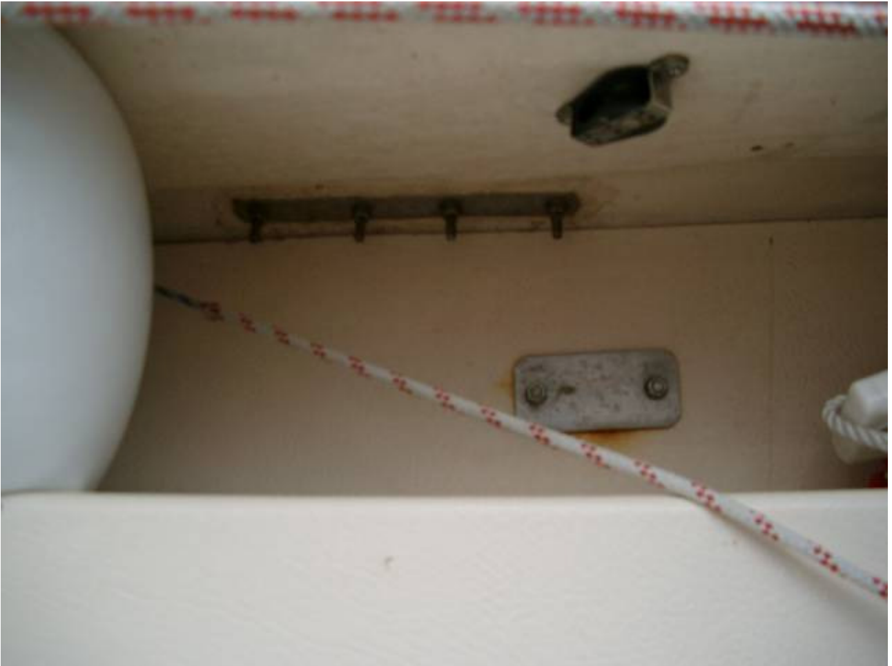
Forstærkninger på undersiden.
